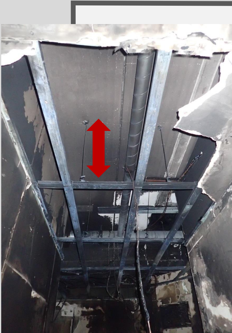
Bereich mit abgehängter Decke, ca. 1m Raum zwischen Dach und abgehängter Decke
